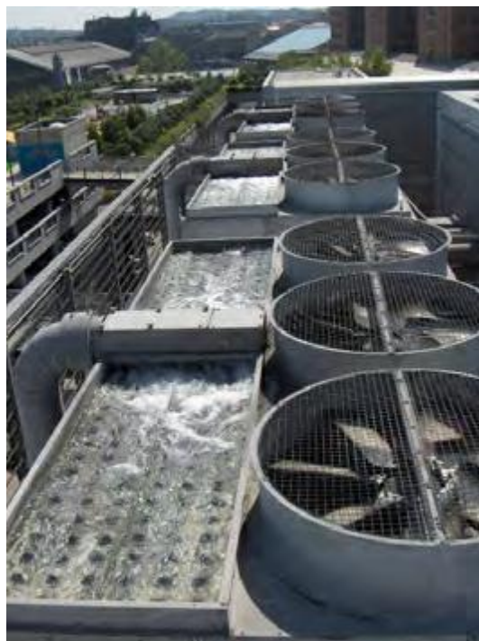
Hình 16.2: Các tháp giải nhiệt kiểu nước bay hơi (the evaporative water cooling tower) trong trung tâm mua sắm West End.
