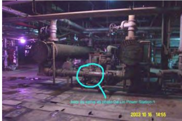
Hình 7.1: Một thiết bị AquaKlear tùy chỉnh 10 inch bảo vệ cho bộ trao đổi nhiệt (Heat Exchangers)
