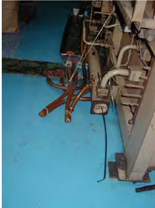
Hình 5.1: Các máy thổi nhựa được bảo vệ bởi HydroFlow. Việc loại bỏ cặn trong tháp giải nhiệt (cooling tower) được cải thiện nhằm làm mát máy thổi nhựa.
