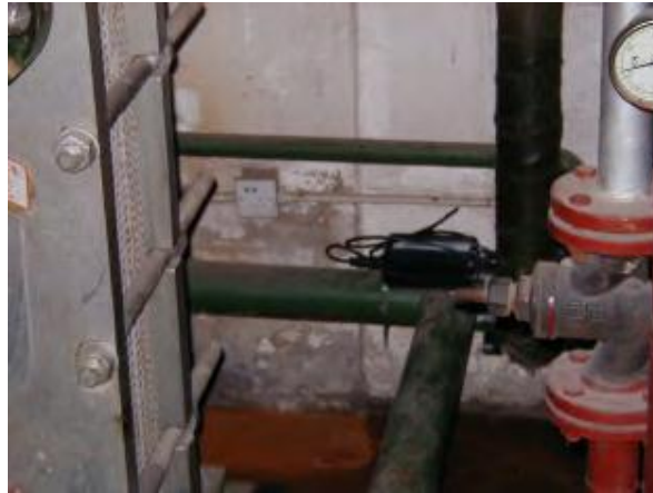
Hình 3.1: The C100 HydroFLOW được sử dụng cho máy trao đổi nhiệt ở cao ốc Shanxi Coal
